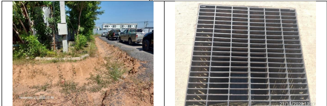
รูปที่ 2-11 รางดิน(ร่องระบายน้ำ) และบ่อดักตะกอนดิน
