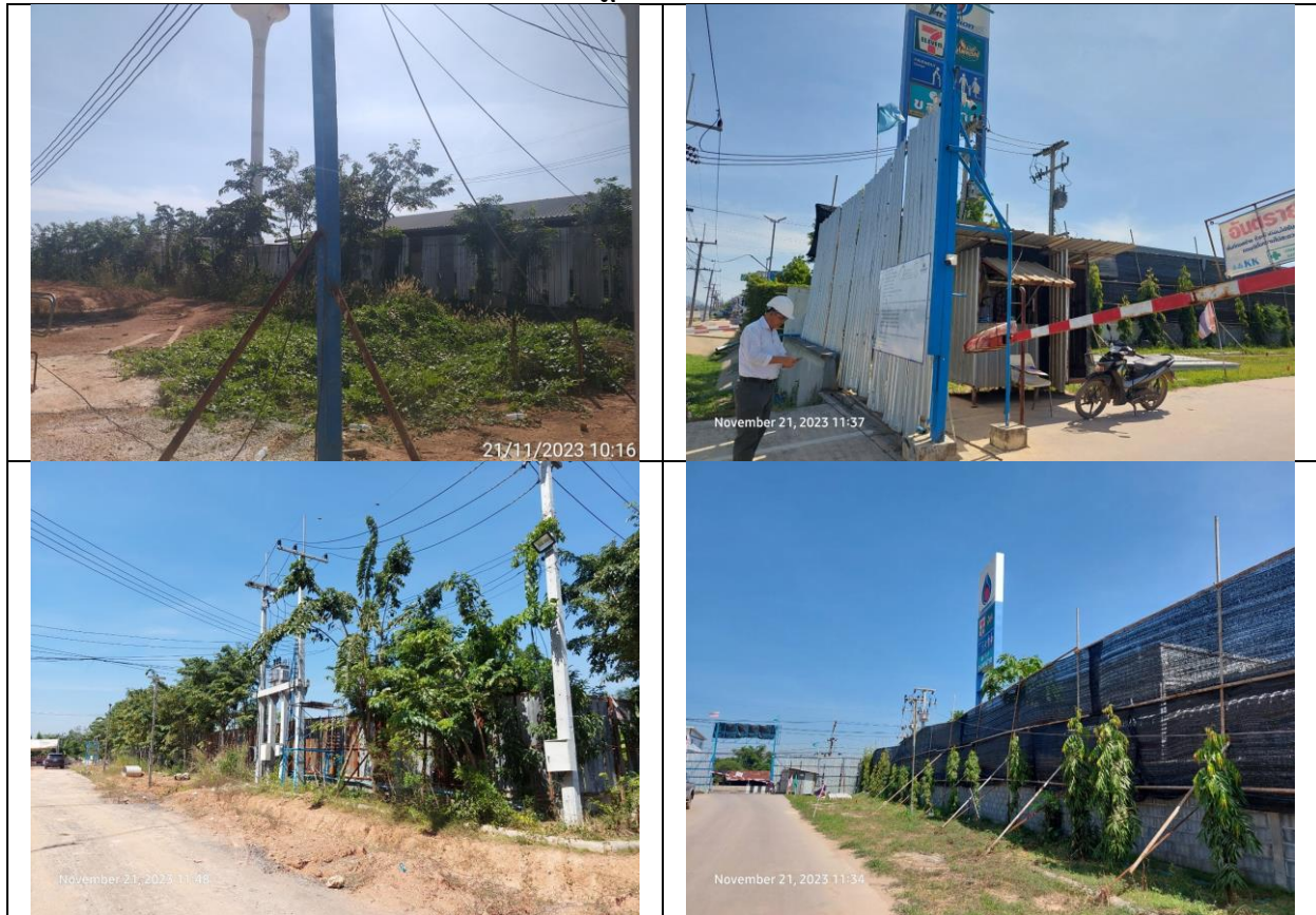
รูปที่ 2-1 รั้ว Metal sheet รอบพื้นที่โครงการพร้อมระบบค้ายัน
